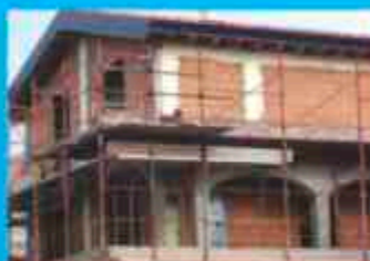
isolamento di pilastri, travi, carree, eliminando il ponte termico
